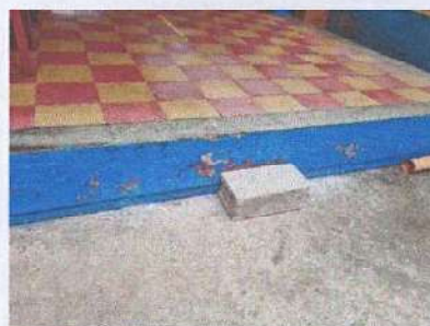
Foto 2: Reparación de piso de granito
