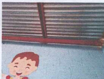
Foto 1: Sustrucción de cubierta de lámina porque es demasiado caliente se sustituirá por troquelada calibre 26 por se la única aula que tiene aún ese tipo de lámina
