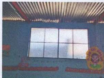
Foto 2: Sustrucción de ventana por ventana pvc
