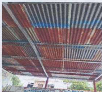
Foto 1: Sustrucción de cubierta de lámina y estructura por daños óxido
