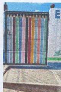
Foto 4: Reparación de grada de ingreso
